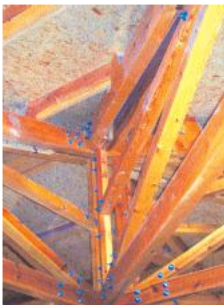
ESTRUCTURA DE MADERA
