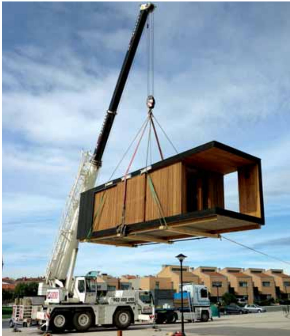
COLOCACIÓN DEL MÓDULO EN SU EMPLAZAMIENTO
