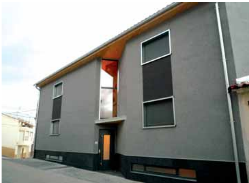
EXTERIORMENTE ACABADAS CON MORTERO DE CEMENTO, NADA HACE PENSAR QUE INTERIORMENTE SEAN DE MADERA
