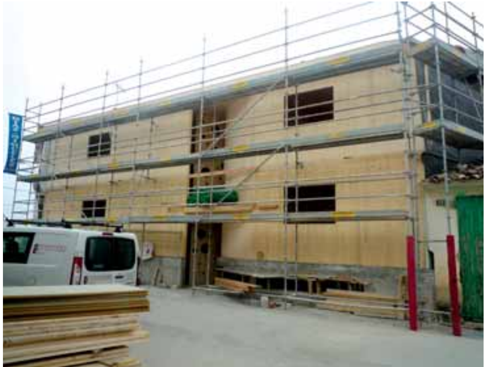
ENSAMBLAJE DE LOS PANELES EN OBRA
