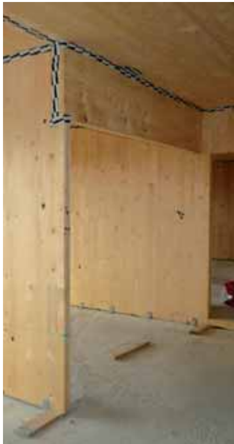
ENCINTADO DE LA ESTRUCTURA
