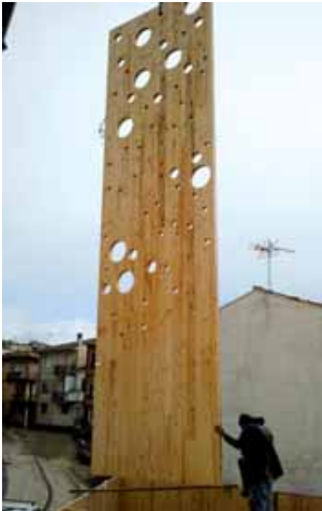
COLOCACIÓN DEL MURO DEL NÚCLEO DE COMUNICACIONES
