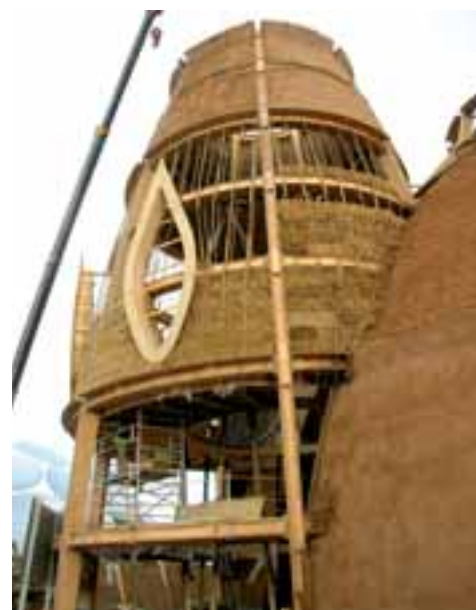
PABELLÓN FARO EXPO ZARAGOZA 2008 PRIMER PROYECTO CONSTRUCTIVO EN OBTENER EL CERTIFICADO PEFC
