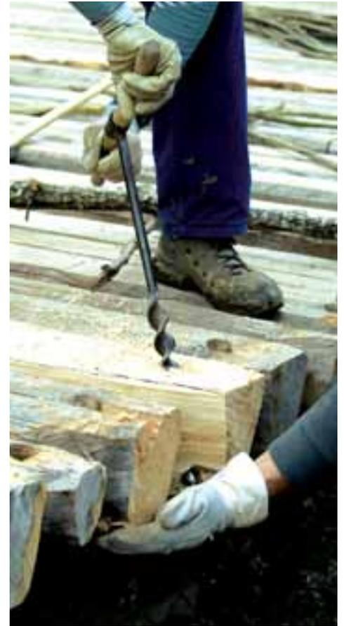
DETALLE DEL BARRENADO EN LOS TRONCOS
