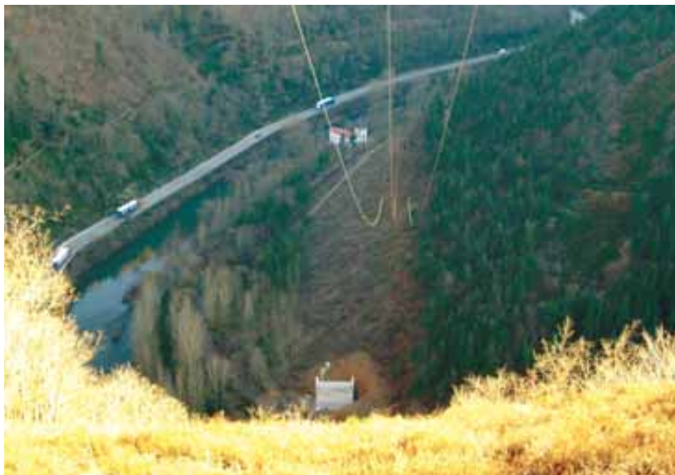
LAS SERVIDUMBRES DE PASO A LAS LÍNEAS ELÉCTRICAS CONLLEVAN LA ELIMINACIÓN DE LA VEGETACIÓN ARBÓREA
