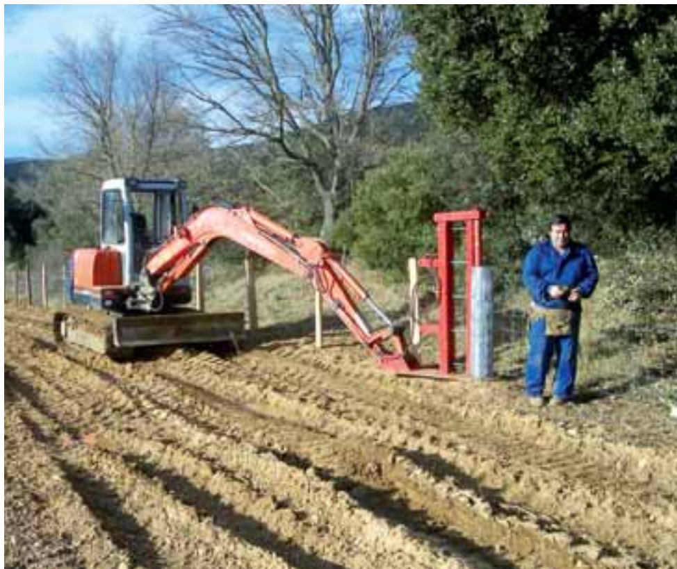
DETALLE DE LA INSTALACIÓN DE UN CIERRE EN LA LOCALIDAD DE ANCIN
