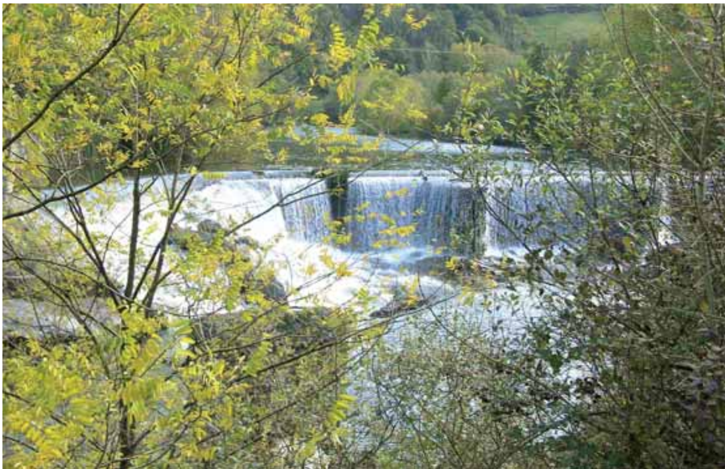
PRESA EN RÍO SALMONÍCOLA
