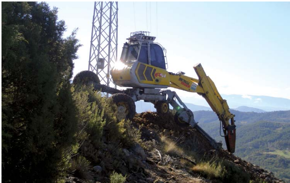
RETROARAÑA EN EXCAVACIÓN PARA COLOCACIÓN DE APOYOS
